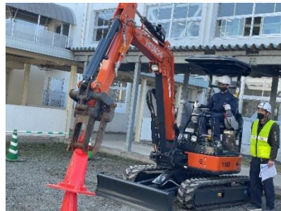
解体工事の様子
