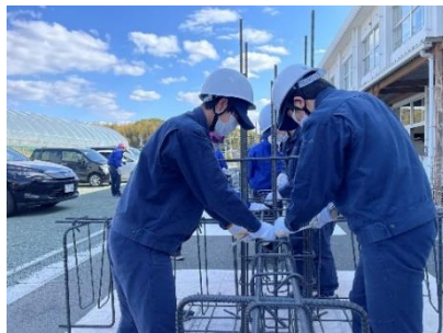
鉄筋結束の様子
