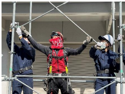
足場設置の様子
