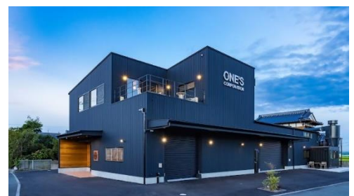
設置場所外観
