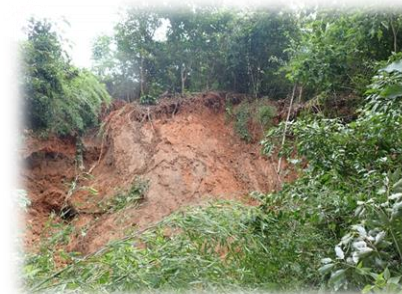
<大宰府学校院跡の被害状況>
