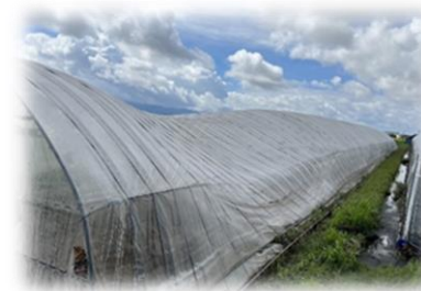
<被災したイチゴハウス>
