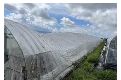
▲被災したイチゴハウス
