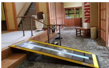
折りたたみ式の簡易スロープの設置
