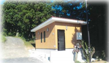
キャンプ場のトイレ整備
