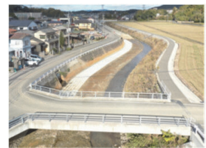
河川の護岸工事
