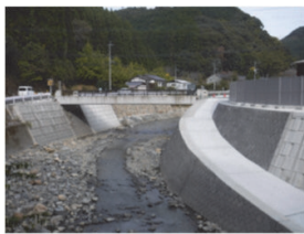
災害復旧工事
