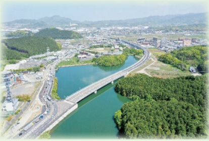
筑紫野古賀線（道路整備）
