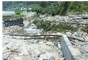
■筑前岩屋駅付近（土砂流入）
