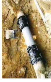
漏水防止のための整備
