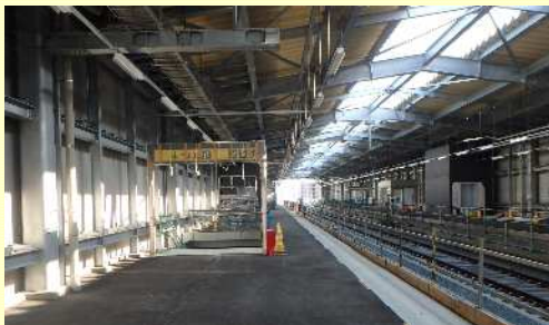
白木原駅ホーム部(高架上大牟田方面望む)
