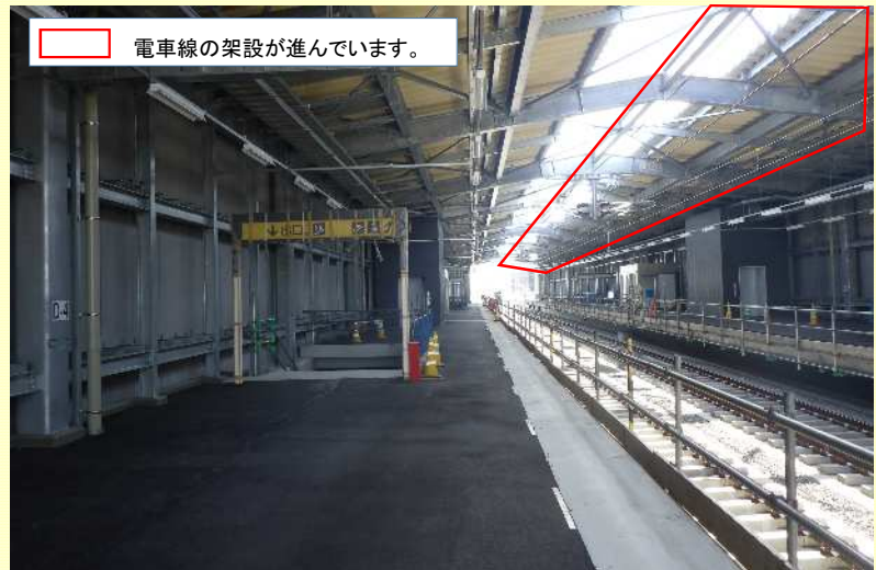
白木原駅ホーム部(高架上大牟田方面望む)
