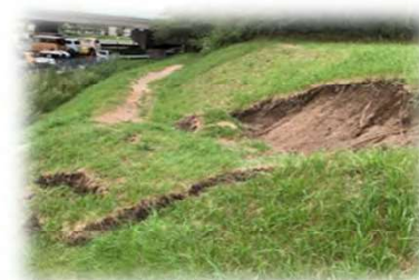
<水城跡の法面崩壊>
