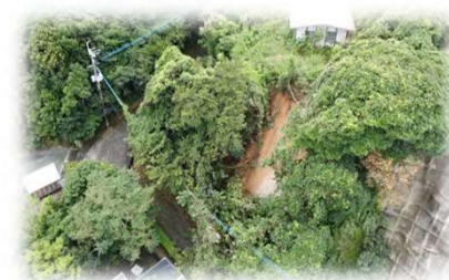
<がけ崩れの状況>
