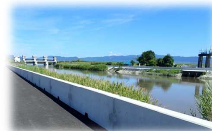
<河川の護岸整備(工事後)>
