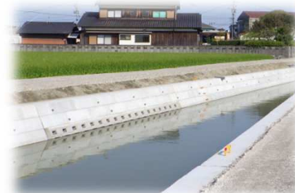
<用排水路整備(工事後)>
