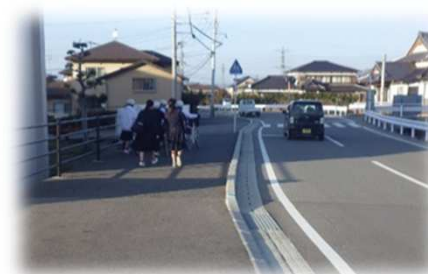
<歩道整備(工事後)>
