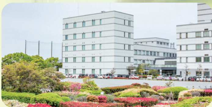
今年4月、久留米市にオープンした福岡バイオイノベーションセンター
