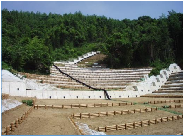
[地すべり防止工（アンカー工）]
