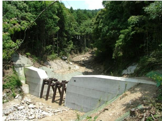
[治山ダム工 (スリットダム工)]
