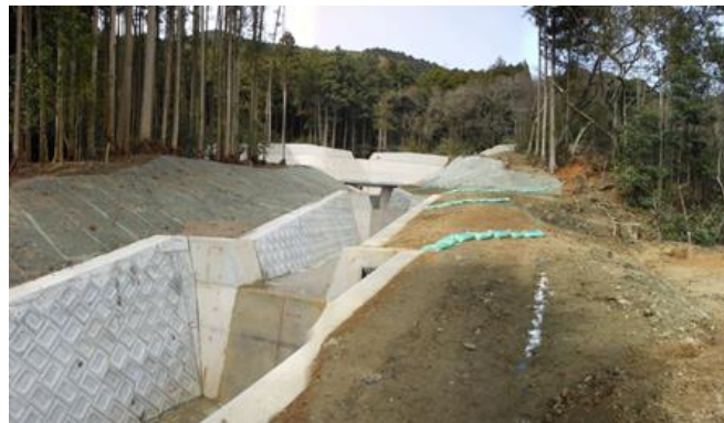
[護岸工、流路工]
