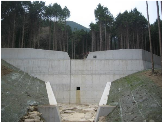
[治山ダム工 (谷止工、床固工)]
