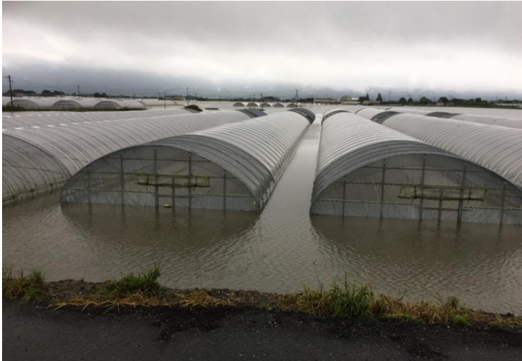
冠水した農作物被災地(久留米市)
