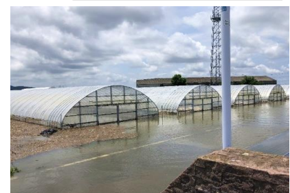
冠水したハウス施設
