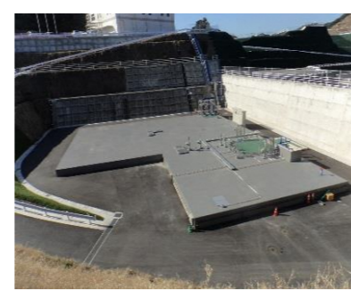
浸出水調整槽
