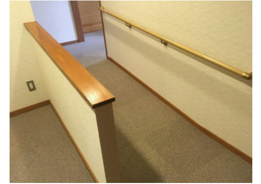
スロープ 出入口までの段差解消
