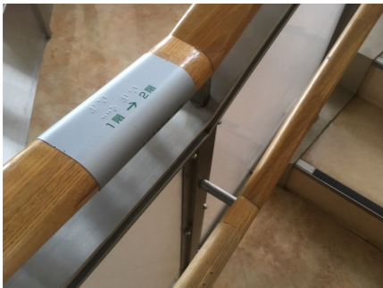
手すり 1階から2階を点字表示
