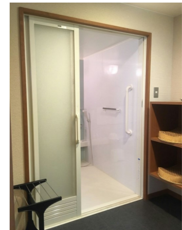
浴室出入口 段差がなく、3枚引戸による幅広い出入口
