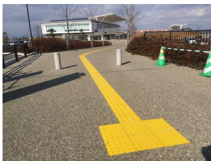
点字ブロック 視覚障害者を出入口まで誘導（道と点字ブロックに明度差をつけて識別しやすいものに）
