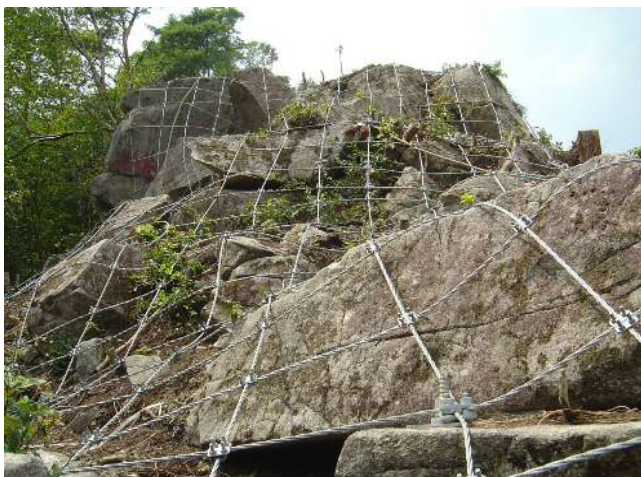
ケーブルネット工(金網なし)
