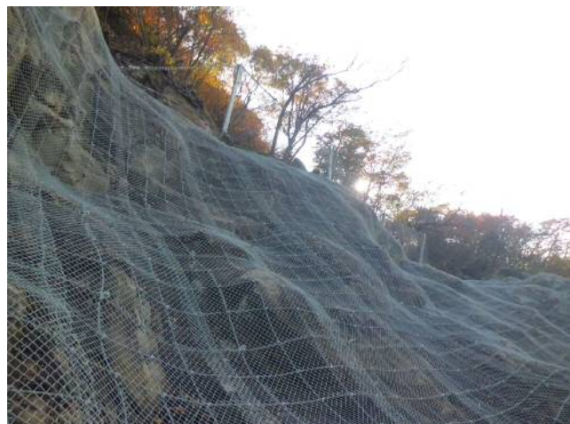
ケーブルネット工(金網あり)
