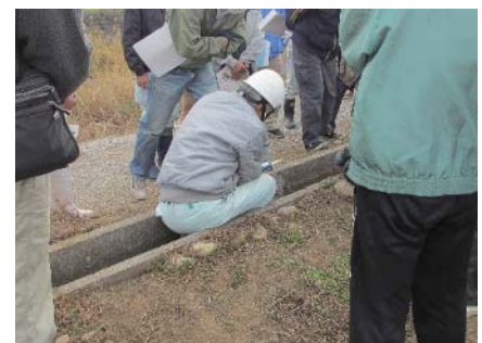
水路補修研修会
