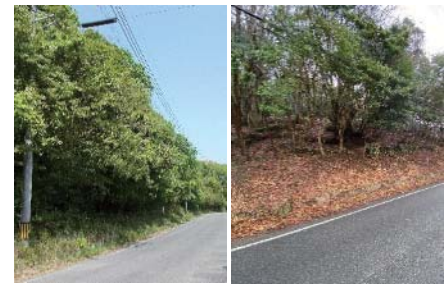
(整備前) (整備後) 緩衝林の整備
