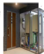
集合住宅向けエネファーム
