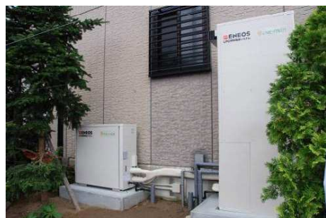
LPG仕様1kW級(家庭用)燃料電池システム
