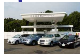
北九州水素ステーション 3kW 燃料電池 1台
