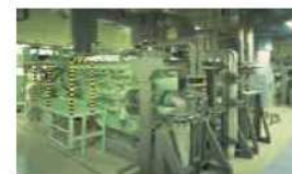
1,000KWクラス ガスエンジン発電設備
