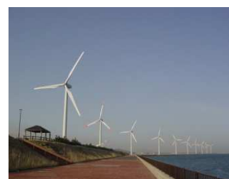
風力発電設備
