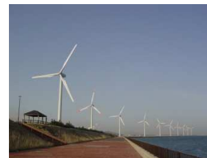
風力発電設備
