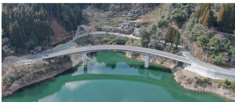
⑧ 一般国道442号 日向神改良Ⅱ期(谷野虹夢橋) (八女市)
