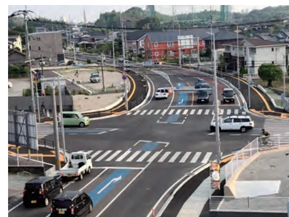
⑩ 一般県道 藤山国分一丁田線 鍵水工区 (久留米市)
