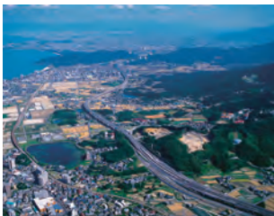
西九州自動車道(福岡前原道路)
