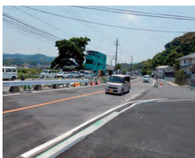
一般国道385号 那珂川拡幅・那珂川拡幅Ⅱ期 (那珂川市)
