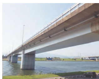
市道A1号線(長門石橋) (久留米市)
