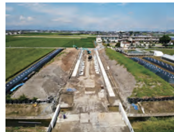
主要地方道 瀬高久留米線 (筑後市)
