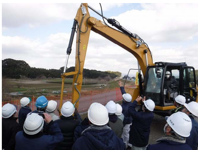
ICT活用工事 (試行) の現場見学会 (みやま市瀬高町)
