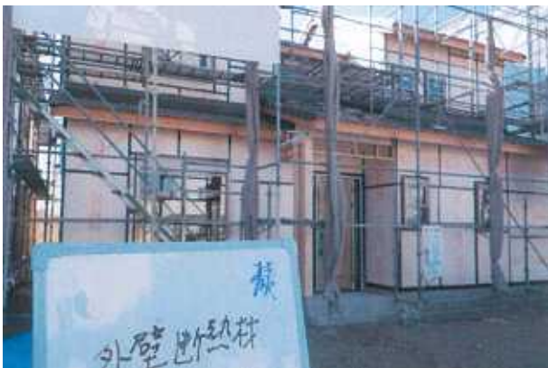
30. 壁断熱材の施工状況
