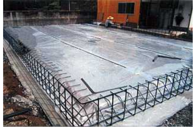
19. 防湿フィルムの施工
