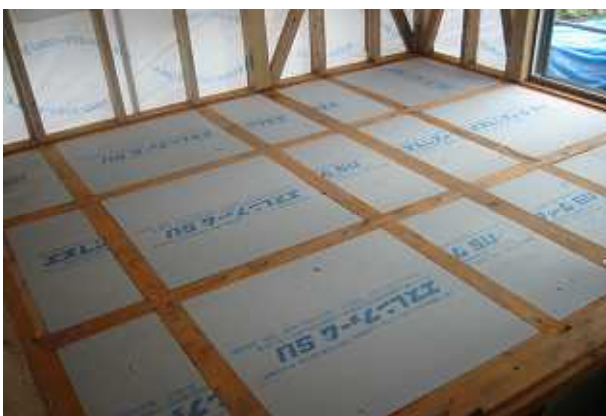
30. 床断熱材の施工状況
