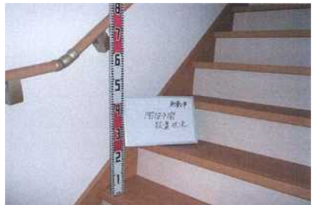
38. 階段手すり設置
