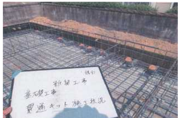
29. コンクリート打設前の配管状況
