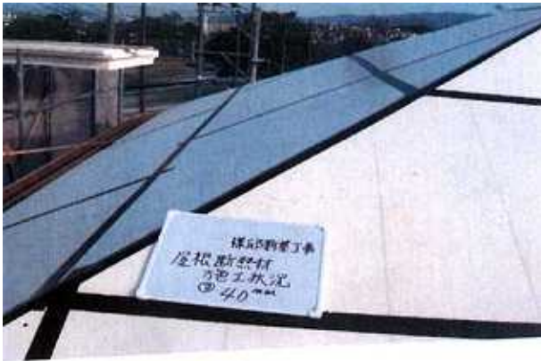
30. 屋根断熱材の施工状況
