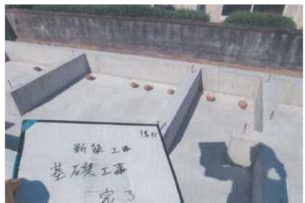
29. コンクリート打設後の配管状況
