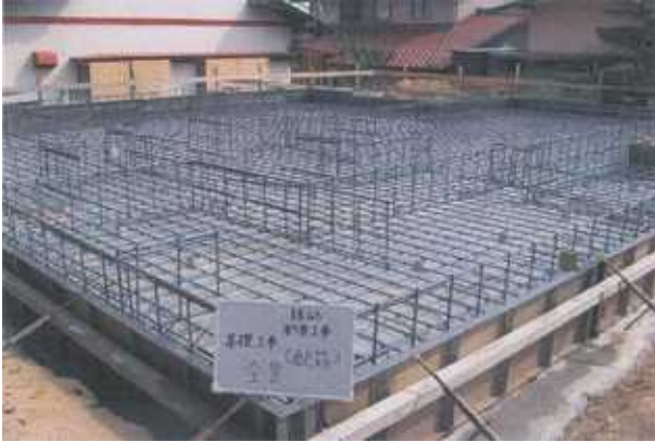
15. 基礎配筋完了
