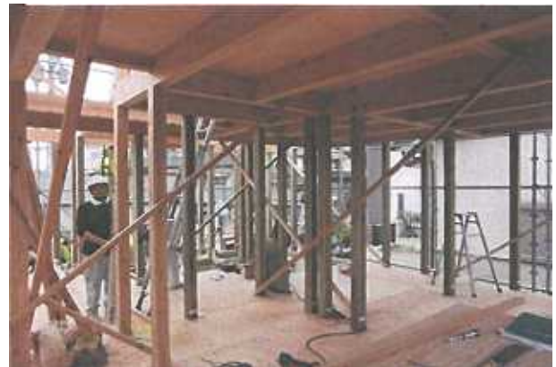
7. 外壁の軸組の防蟻・防蟻処理
