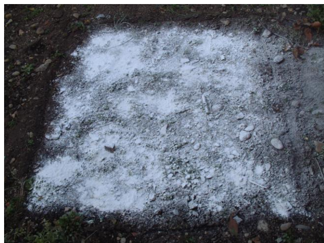
石灰散布目安（写真は 0.5\text{kg}/\text{m}^2 ）
