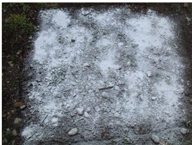
石灰散布目安（写真は 0.5\text{kg}/\text{m}^2 ）
