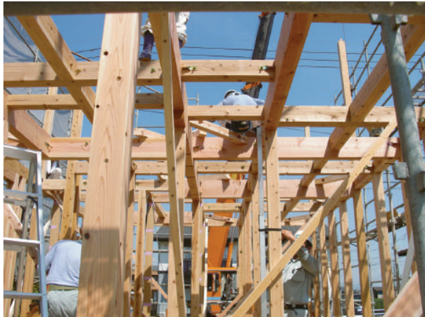
写真 1：在来軸組工法（構法）の施工状況
