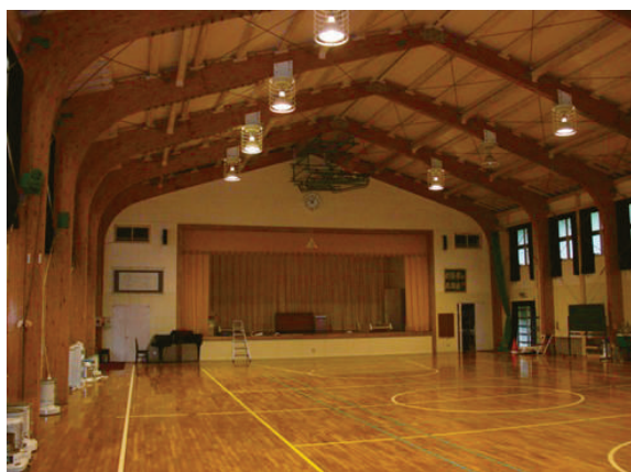
写真 2：木質ラーメン構造によって建てられた体育館 「福岡市立小呂小中学校講堂兼体育館」
