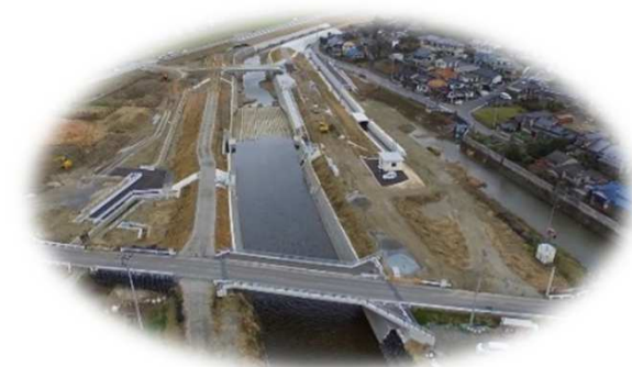
<河川の改良工事>
