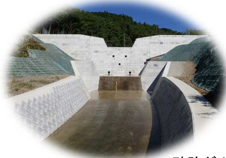
<砂防ダムの整備>
