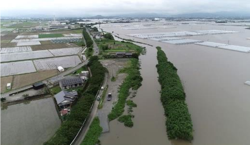
冠水した農作物被災地(久留米市)
