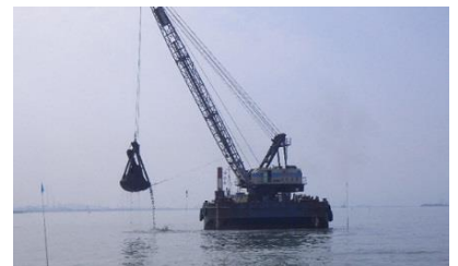
堆積土砂の撤去作業(平成24年度)
