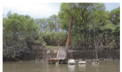
破損した船着場(簡易浮き棧橋)
