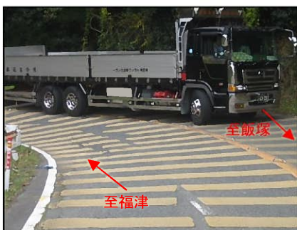
〔現道・見坂峠の線形不良箇所〕
