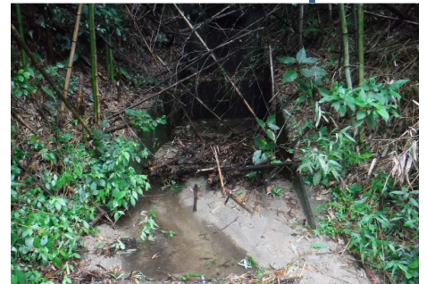
【令和元年施工】 土砂撤去
