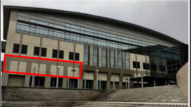
(No.⑤) 事務室・研修室・宿泊室棟東側壁面
