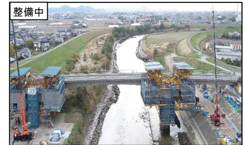
【国道443号「柳瀬大橋」(柳川市、みやま市)】
