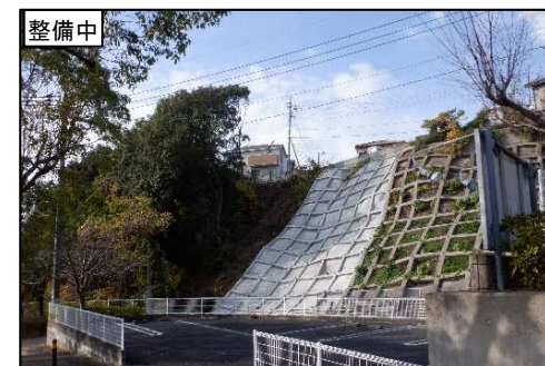
整備中 急傾斜地崩壊対策事業 【船越2丁目地区(北九州市八幡西区)】
