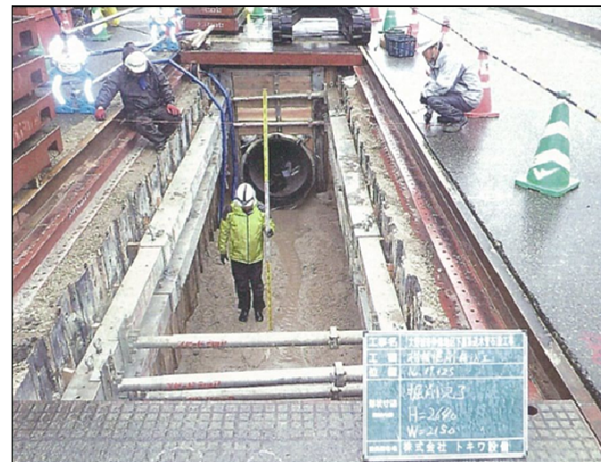
【地震等災害時用の水道管の整備工事】
