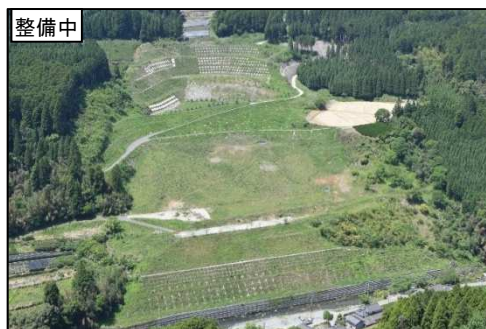
整備中 地すべり対策事業【柳原地区(八女市)】
