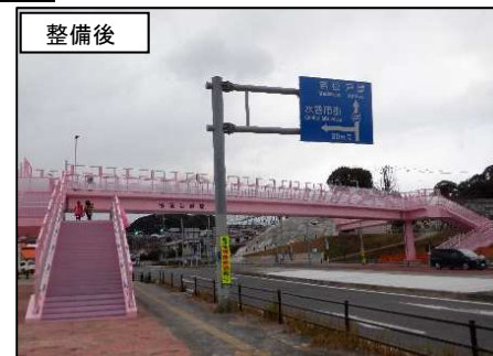
【水巻芦屋線「頃末歩道橋」(水巻町)】
