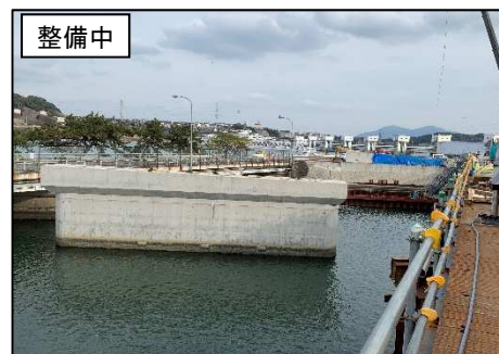
【直方芦屋線「西祇園橋」(芦屋町)】
