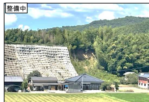
整備中 県単急傾斜地崩壊対策事業 【河原内地区(みやま市)】
