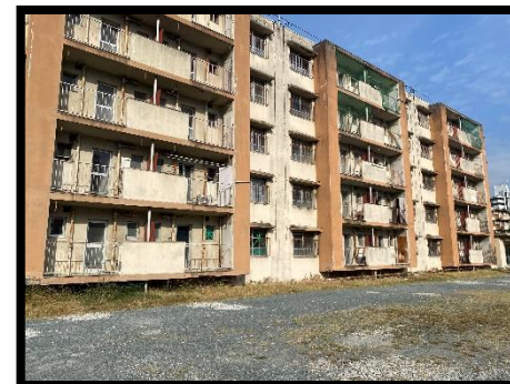
城浜団地建築工事
