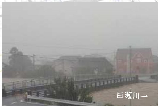
巨瀬川左岸 10k300付近の越水状況
