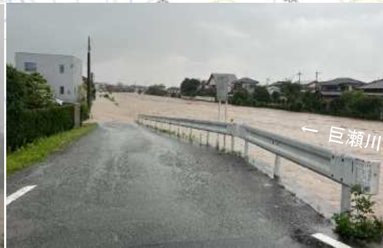
巨瀬川左岸 15k600付近の越水状況
