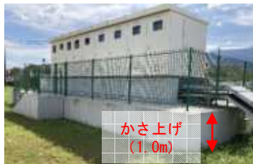
【第1受変電設備】
