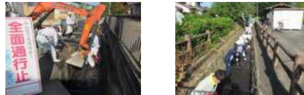
排水路の土砂撤去状況(久留米市田主丸町)
