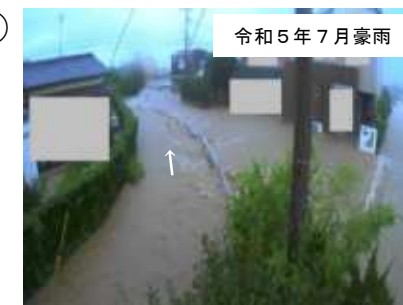
山曾谷川の溢水状況
