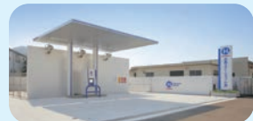
水素ステーション
