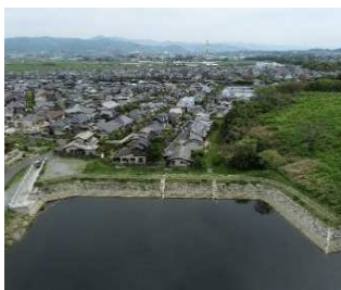
防災重点農業用ため池
