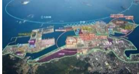
エネルギー関連施設が集積する響灘臨海部
