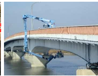
橋梁定期点検
