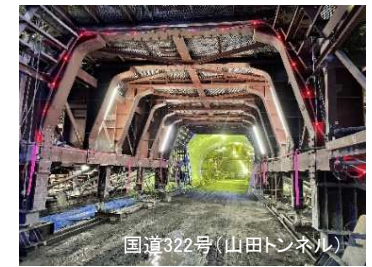
バイパス整備
