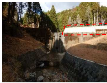
砂防堰堤修繕
