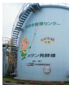
菌の働きで有機物を分解してメタンガスを作る発酵槽
