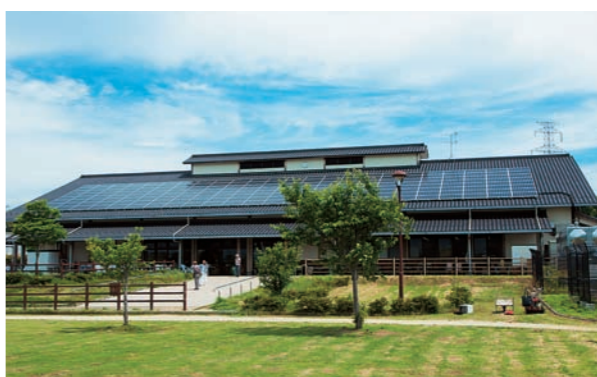
日当たりの良さを生かして屋根に192枚の太陽光パネルを設置。家庭10世帯分に相当する電力を発電中
