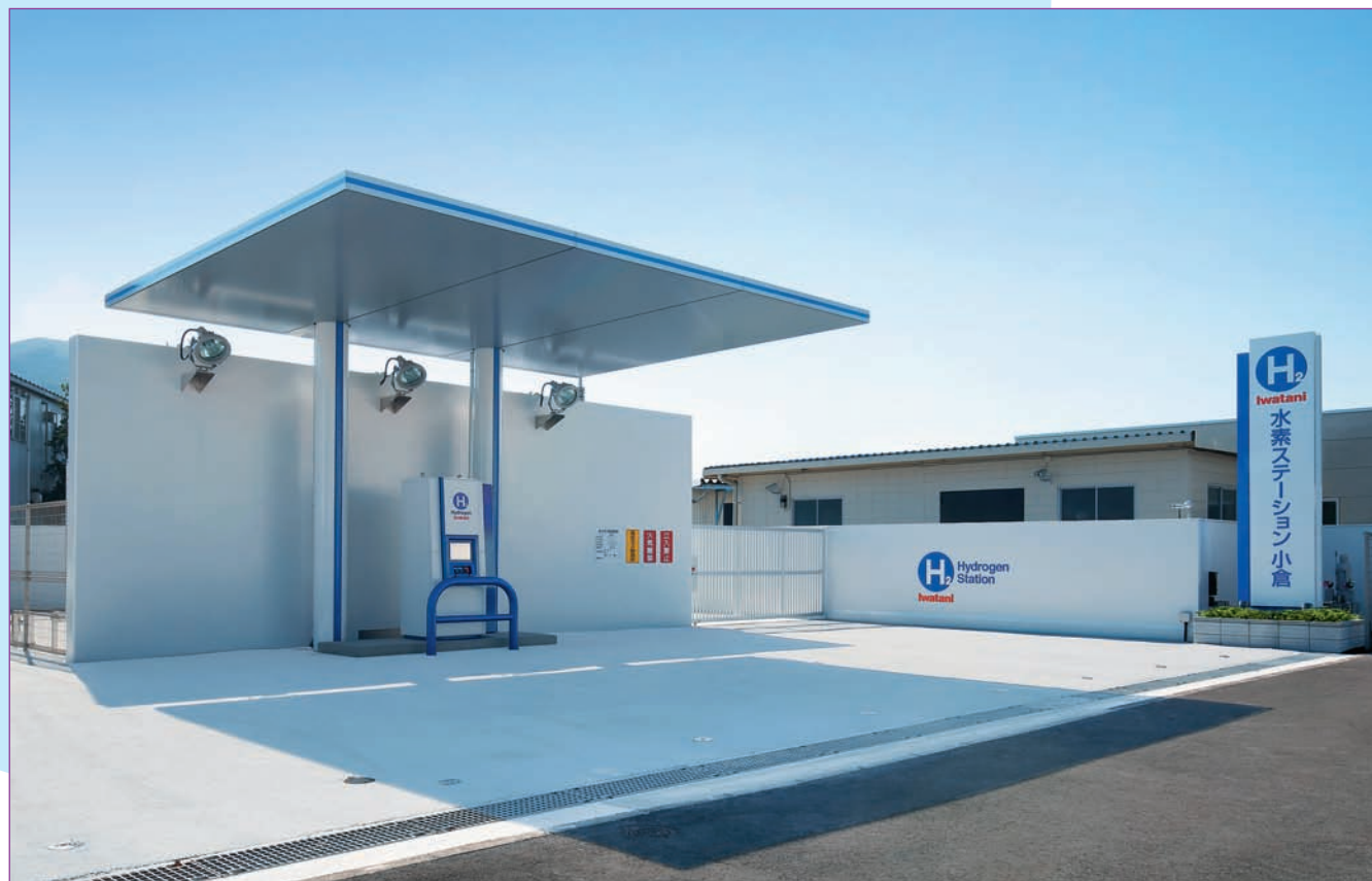
10月22日に九州では初となる商用水素ステーションとしてオープンした「イワタニ水素ステーション小倉」
