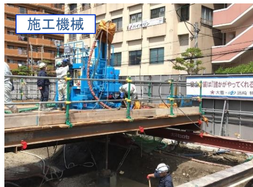
地盤改良状況
