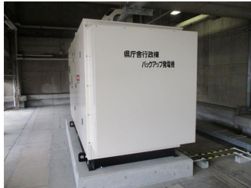
(左：県本庁舎地下非常用電源設備、右：県本庁舎10階バックアップ非常用電源設備)
