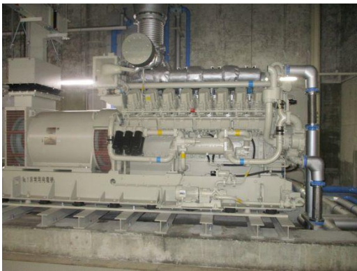
(左：県本庁舎地下非常用電源設備、右：県本庁舎10階バックアップ非常用電源設備)
