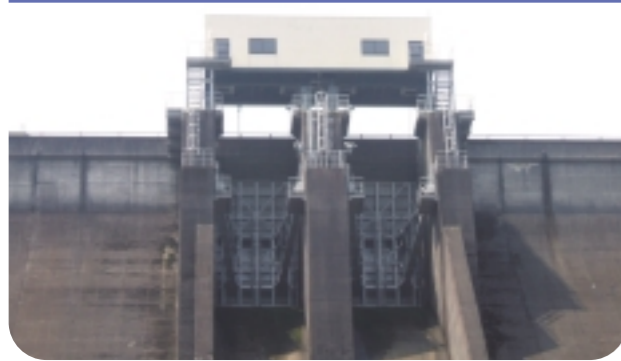
洪水時にダムから下流に流す水量を調節するためのゲートです。
