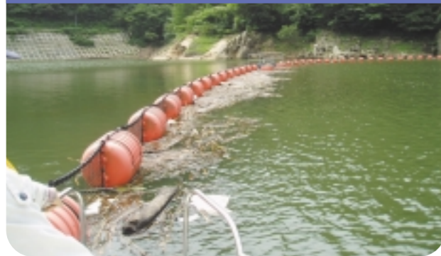
ゲート等に流木が流れこむのを防ぐための設備です。
