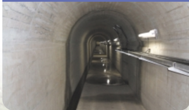
ダム本体内部のひび割れや漏水量を調査・測定するための通路です。
