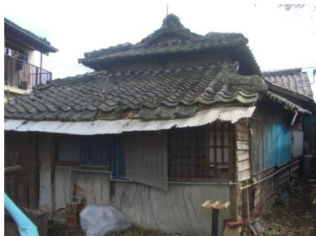
空家の全景写真
