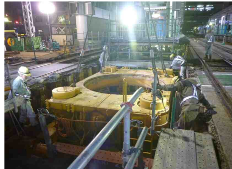
(春日原駅) 夜間施工の状況です。 夜間作業は、最終電車通過後のき電停止から始発電車運行の 停電解除までの3時間で行います。 駅部の工事は、仮設ホーム撤去 → 新しい高架橋駅の工事 → 仮設ホームの再設置を繰り返しながらの工事であり、 限られた短い時間の中で施工を行っています。
