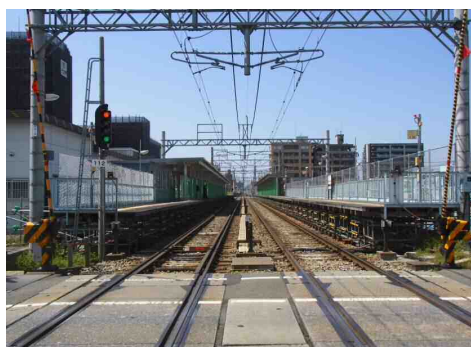
(白木原駅) 仮設ホームの設置状況です。 春日原駅と同様に夜間施工での作業です。
