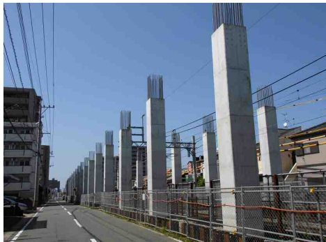
(春日原駅～白木原駅) この区間は高架橋を先行して建設しており、線路の両側には 高架橋の柱が立ち並んでいます。
