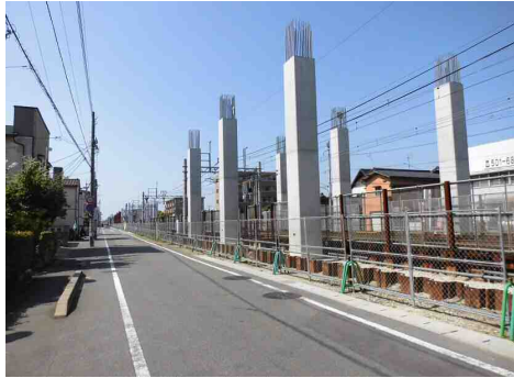
(福岡市境～春日原駅) 高架橋の建設を進めています。
